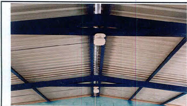
Foto 3: se observa el mantenimiento de la estructura metalica del techo del establecimiento.
