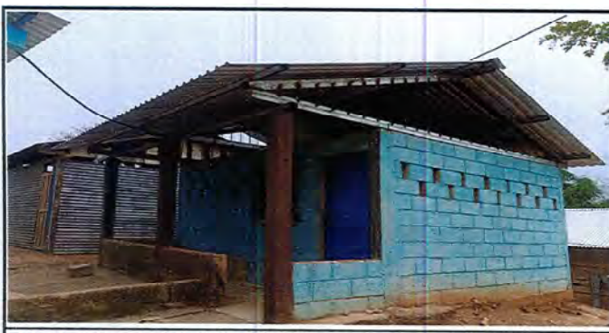
Foto 5: se observa el suministro de lamina y estructura metalica del entechado de la cocina del establecimiento.
