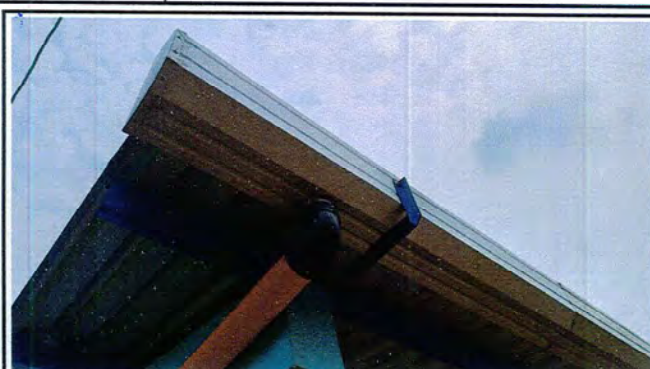
Foto 2: se observa el suministro del canal y bajada del agua pluvial.
